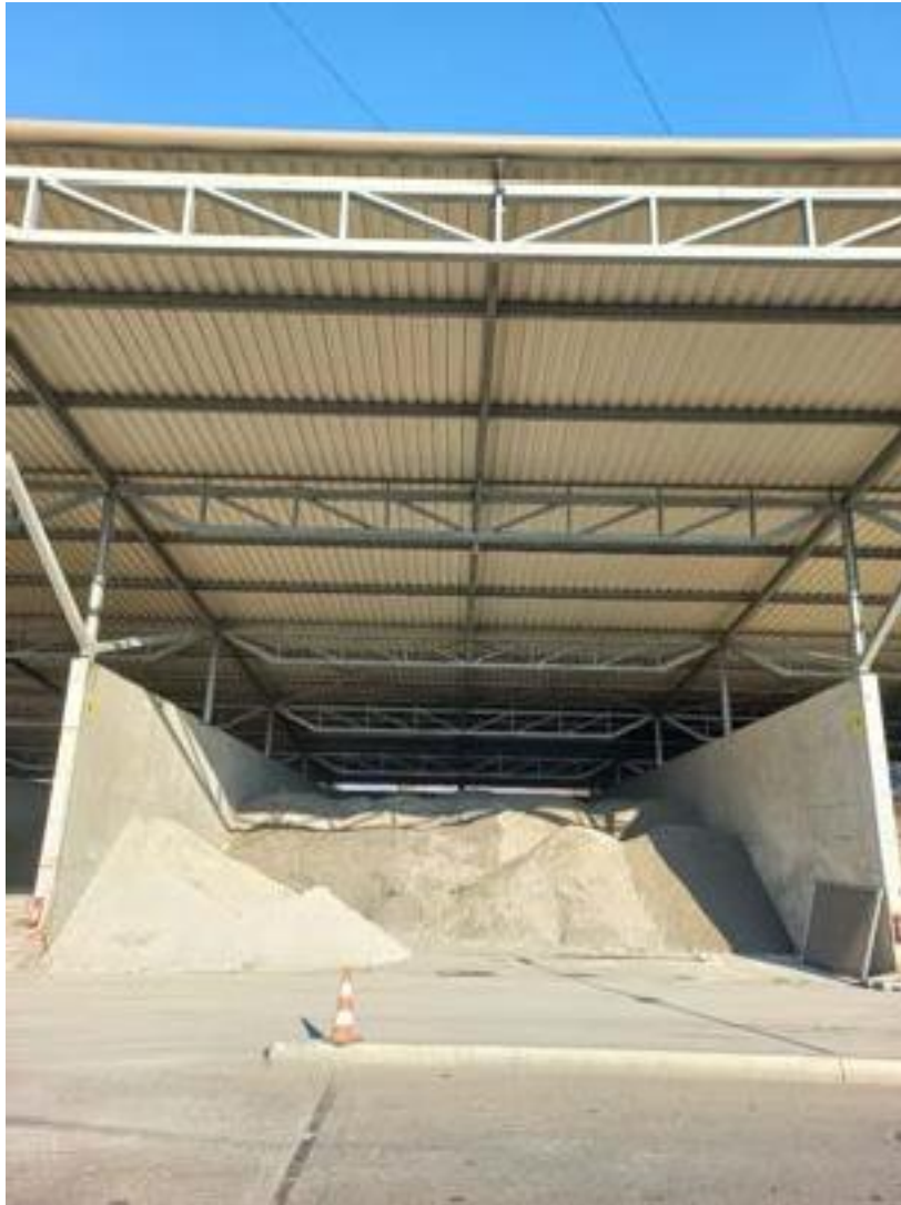
Figure 9. Vue de face d'une alvéole (photo non représentative du stockage de déchets ménagers)
